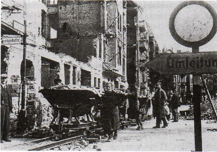
Восстановительные работы в Берлине. 1946 г.
