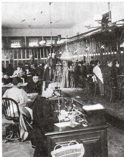
На телефонной станции
